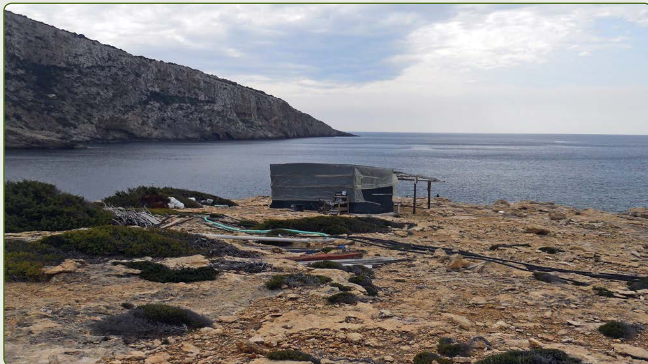
Εικόνα 14: Αυθαίρετη προσωρινή κατασκευή στην τοποθεσία Πόντες-Βαθύ Δήμου Φαιστού, 2015.
